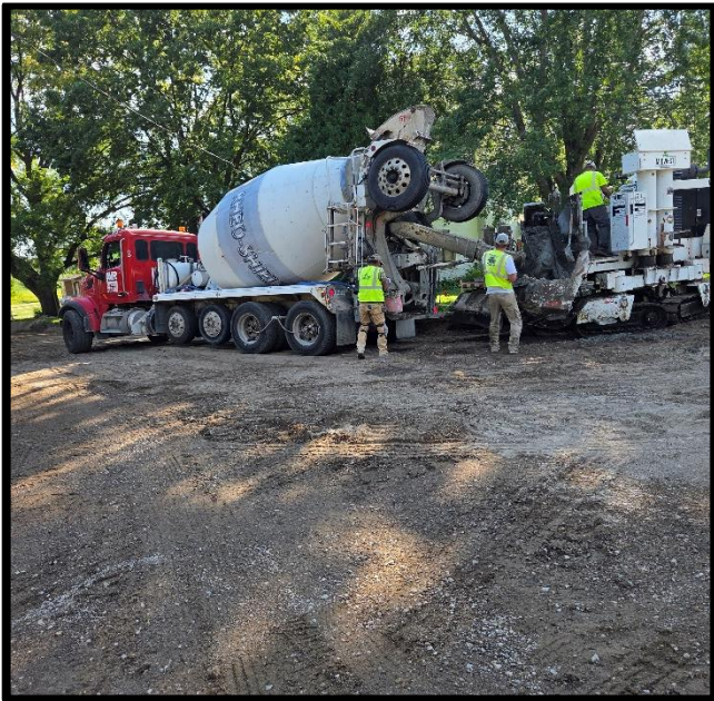
Concrete curb and gutter pour backs
